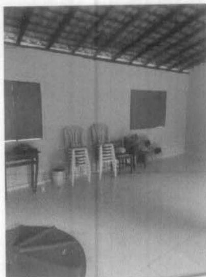
Imagem 3 – Execução do Piso
