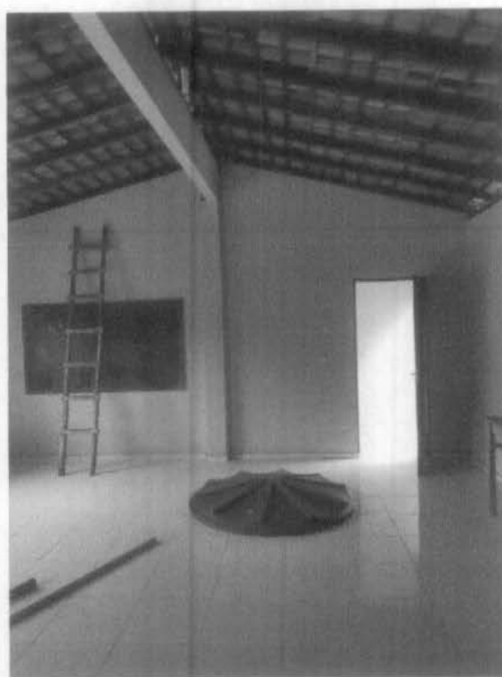
Imagem 6 – Revisão da Cobertura
