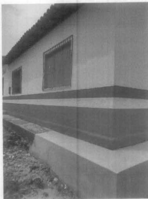
Imagem 2– Pintura das Esquadrias
